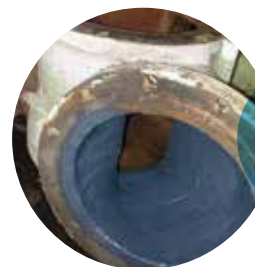
容器承压 件修补
